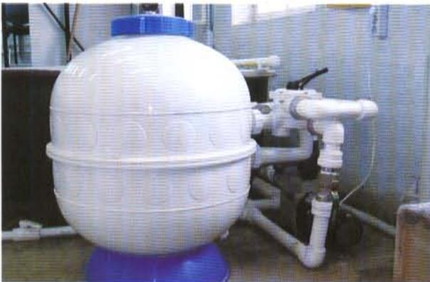
Рис. 32. Механический фильтр
