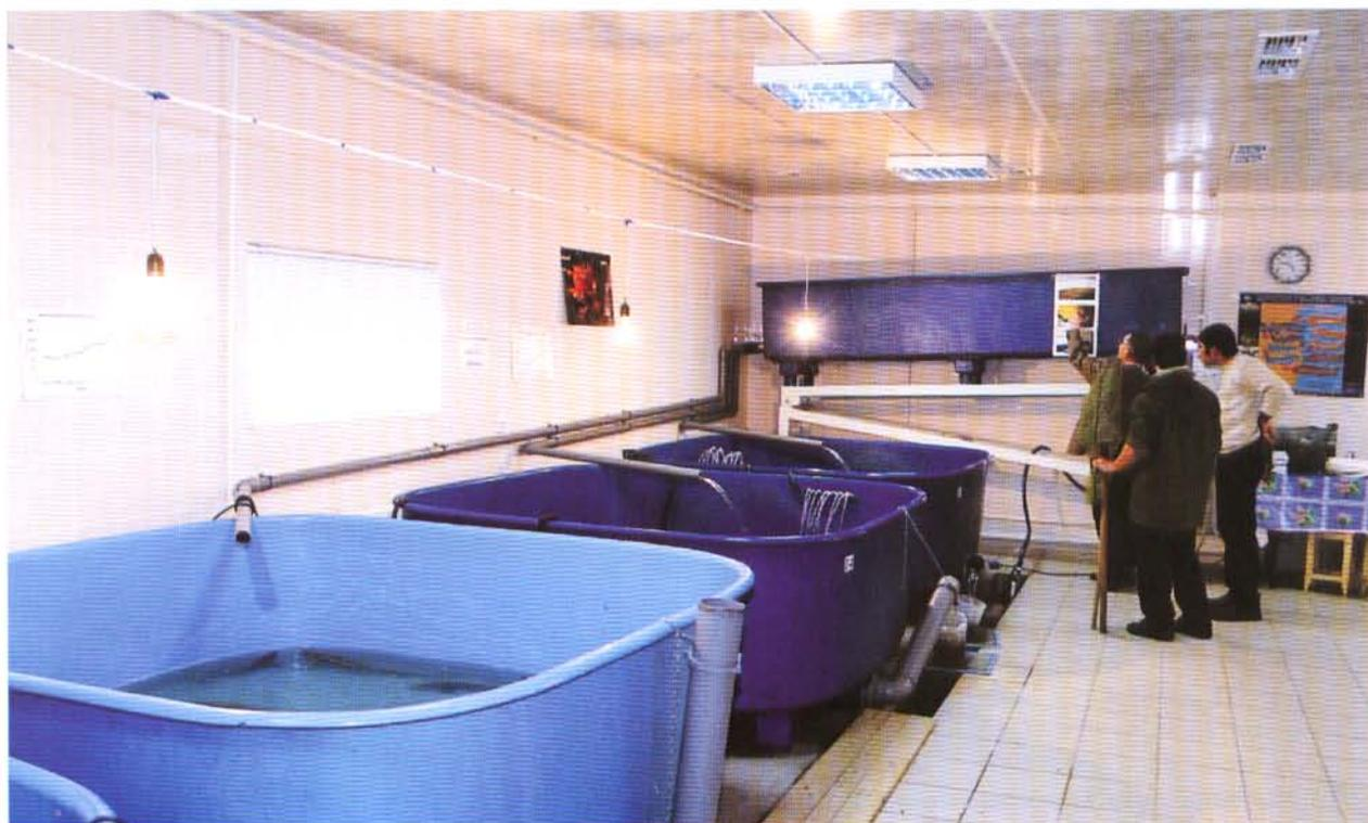
Рис. 28. Установка замкнутого водообеспечения в рыбоводном комплексе «Кагальник»
