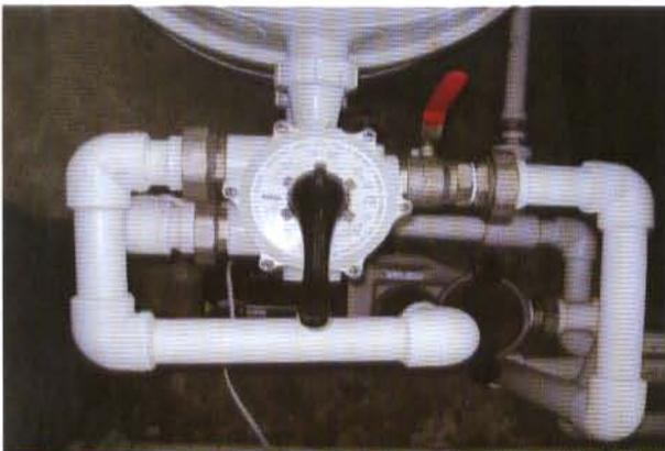
Рис. 33. Блок управления работой механического фильтра
